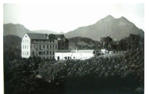
Seminário visto dos fundos com sua nova area construida do Livro Cronicas do Pe. Schmidt 1936. Ao fundo, outro cartão postal de Corupá
